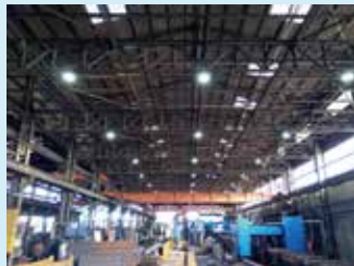
某鋼構造物製作メーカー様
