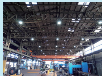
某鋼構造物製作メーカー様
